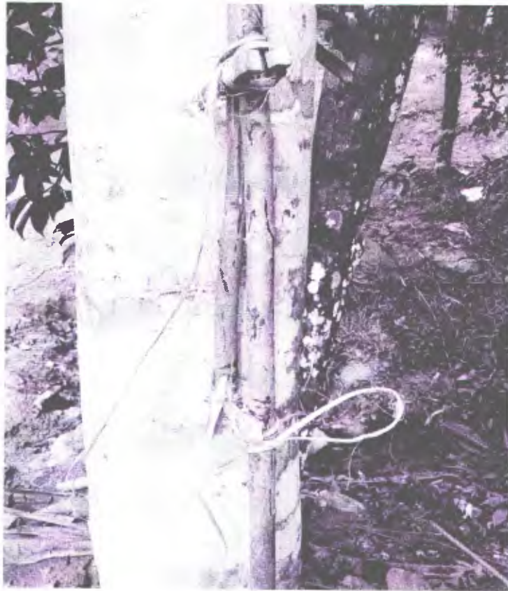
ภาพที่ 24 ตัวอย่างการต่อไม้แม่ร่อง (ที่มา: เมธิรา ไกรนที, 2559)
