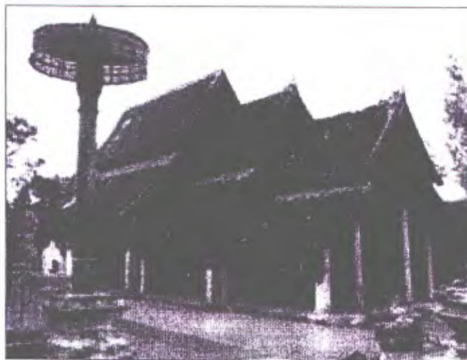
ภาพที่ 2.8 วิหารน้ำแต้ม วัดพระธาตุลำปางหลวง จ.ลำปาง ตัวอย่างโบราณสถานที่สร้างด้วยไม้
