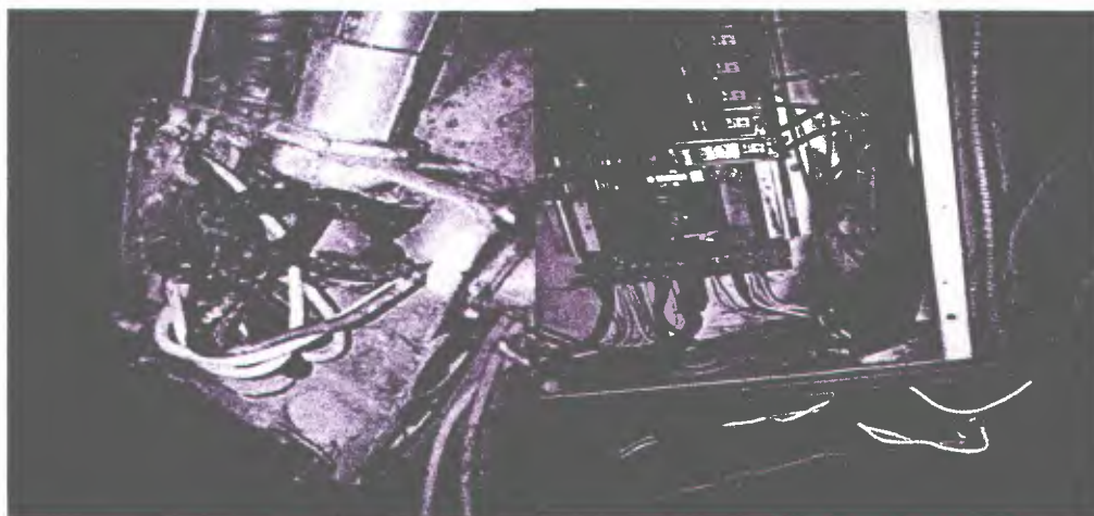
รูปที่ 3 การเชื่อมต่อสายตามจุดแยกต่างๆ ที่อาจทำให้เกิดการเผาไหม้
