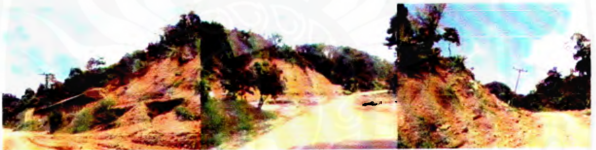
ภาพที่ 1.18 ภาพแสดงแผ่นดินถล่มไหลลงจากภูเขา ในเขตอำเภอนบพิตำ วันที่ 16 พฤษภาคม 2554
