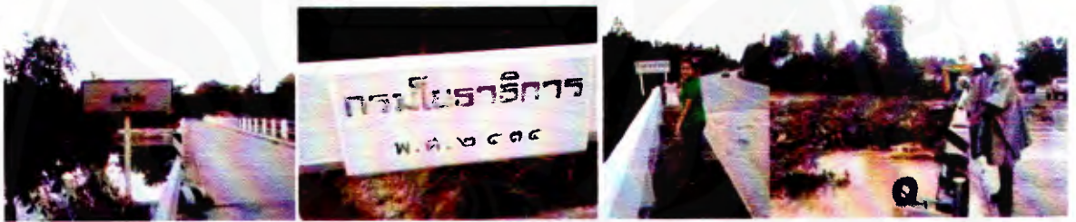
ภาพที่ 1.10 ภาพแสดงสิ่งกีดขวางที่เกิดจากเส้นทางคมนาคมขวางทางการระบายน้ำลงทะเล สะพานบางจุดสั้นไม่เหมาะกับปริมาณน้ำมาก และถนนที่ยกสูงทำให้น้ำระบายออกได้ช้า น้ำต้องหาทางระบายตามช่องทางที่พอจะไหลได้ สิ่งก่อสร้างเหล่านี้จัดสร้างโดยกรมโยธาธิการ
