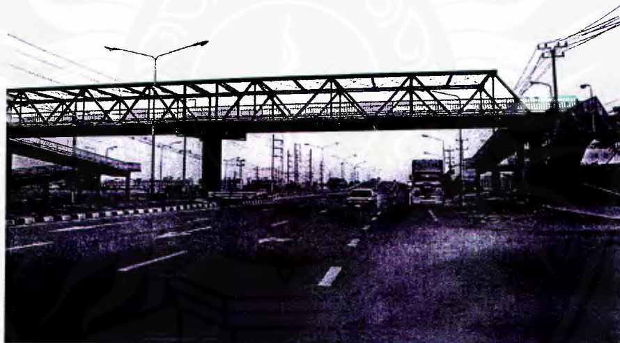
รูปที่ 4.7 สะพานลอยจักรยานยนต์ ถนนชลบุรี-บ้านบึง จังหวัดชลบุรี
