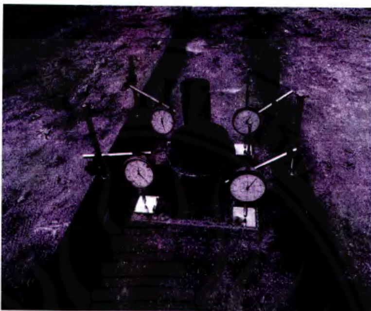
รูปที่ ๒๖ ติดตั้งไดอัลเกจไว้บนมุมทั้งสี่ของแผ่นเหล็ก
