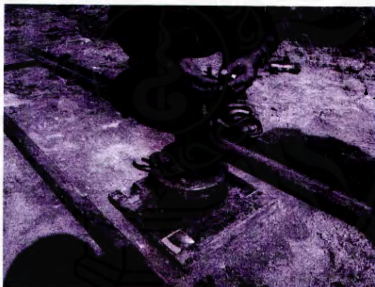
รูปที่ ๒25 วางแผ่นเหล็กทุกแผ่นให้ร่วมศูนย์กัน
